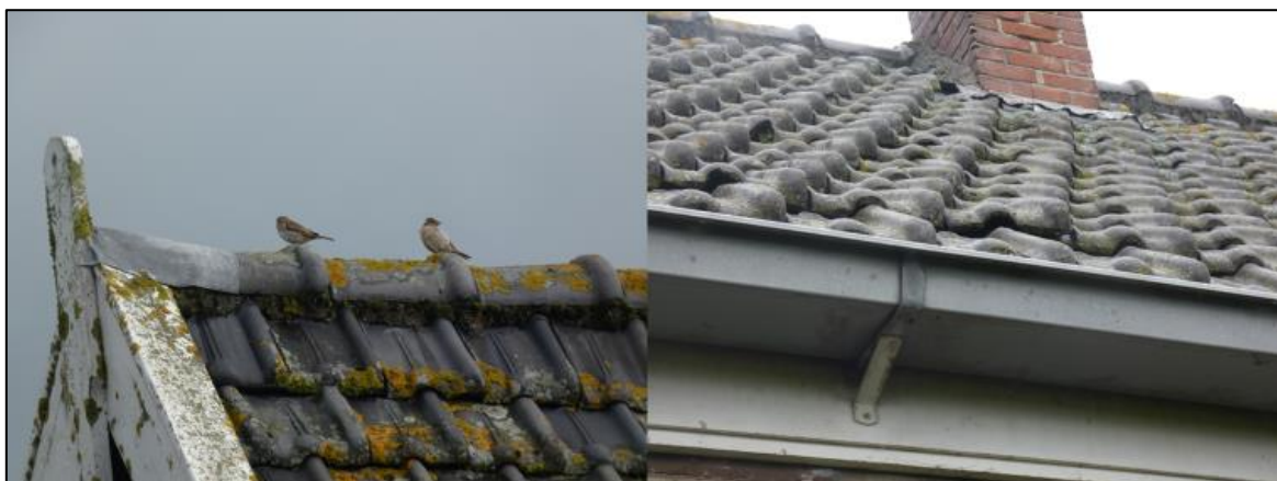
Figuur 3.2 Huismussen op het dak van de bedrijfswoning en de geschikte nestlocaties voor de huismus.
