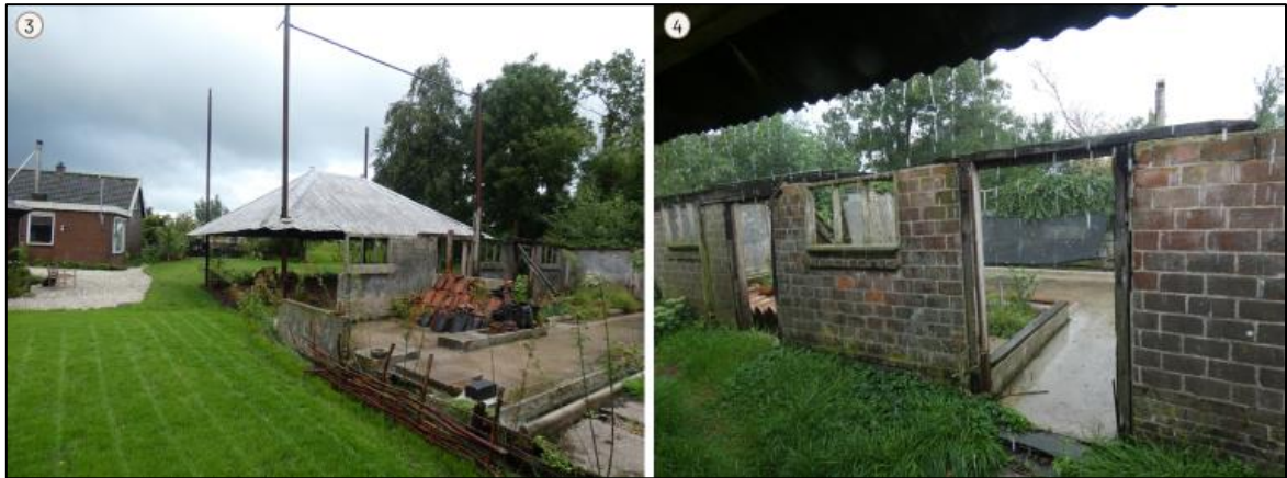
Figuur 1.3 Op de planlocatie is men voornemens om de volgende gebouwen te slopen: de overkapping (3) en het voormalige bijgebouw (4).
