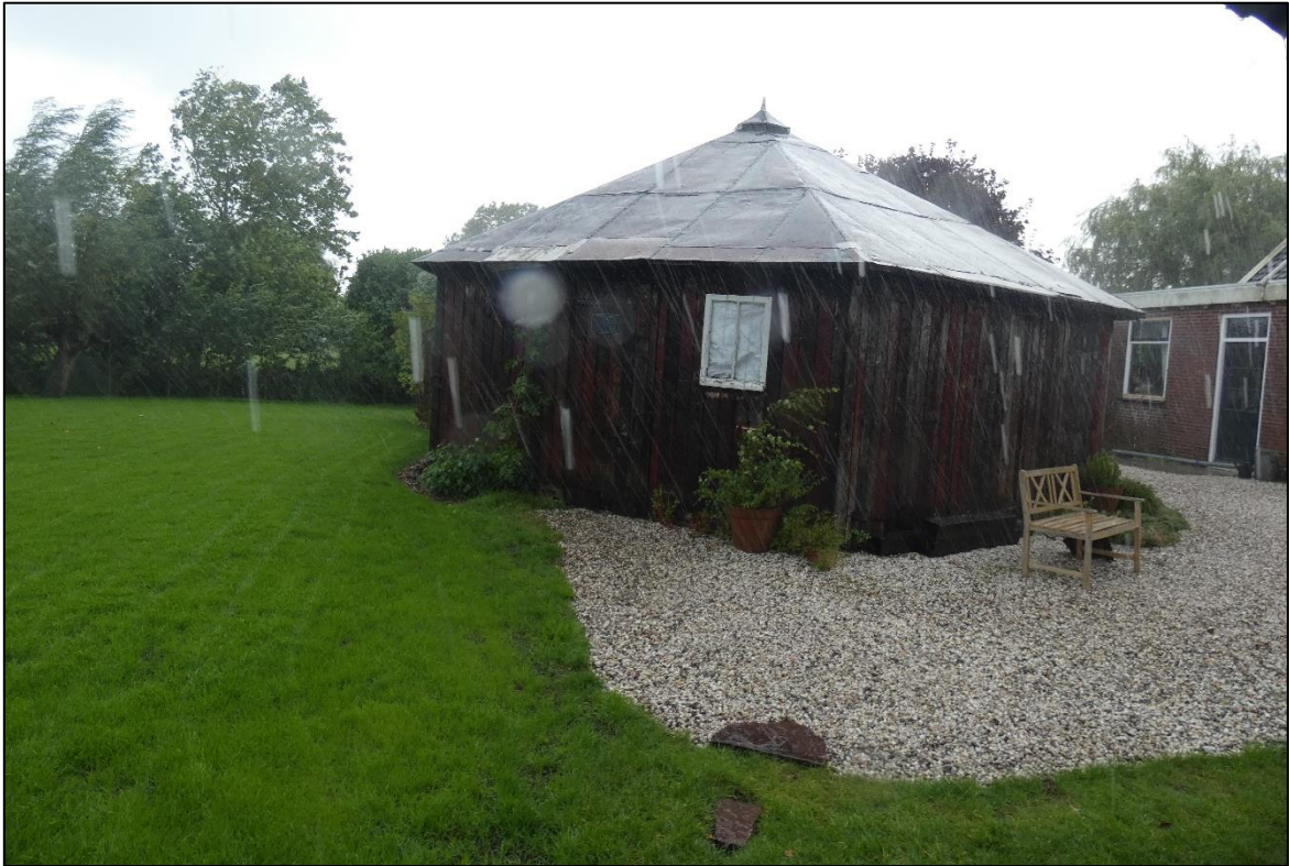
Figuur 3 De bebouwing bestaat uit een schuur opgetrokken uit hout met een puntvormig dak bestaande uit een loden dakbedekking.
