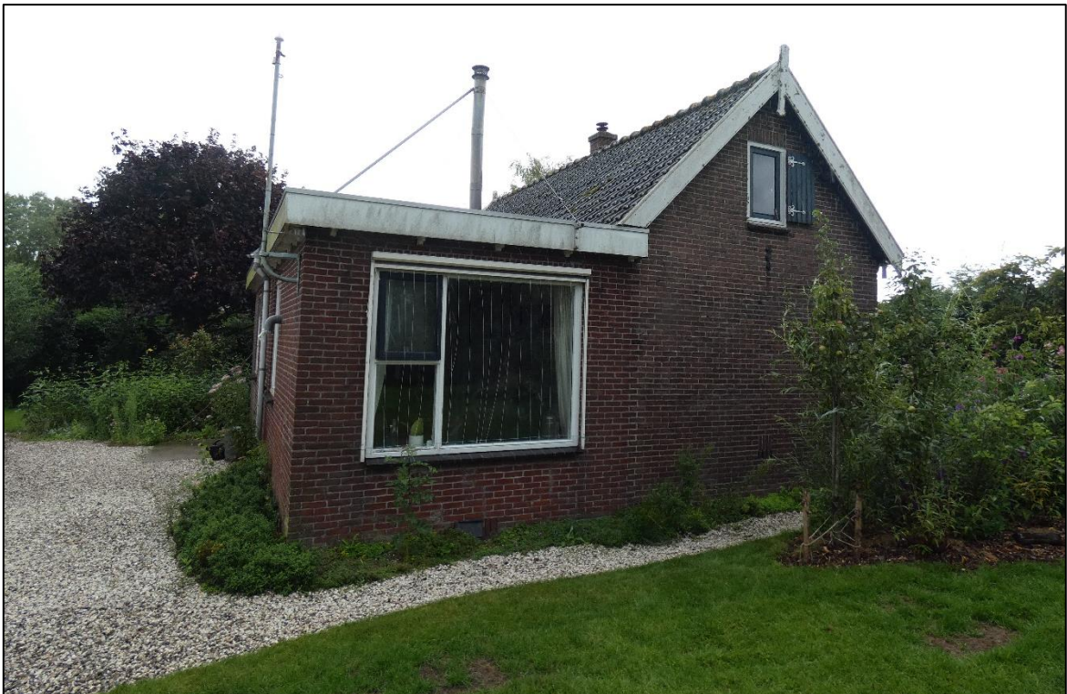
Figuur 2 De bebouwing bestaat uit een voormalige bedrijfswoning opgetrokken uit bakstenen muren met een luchtspouw en heeft een dakpannen zadeldak. De gevels zijn bovenaan afgewerkt met een houten daklijst. De woning heeft aan aanbouw met een plat dak.
