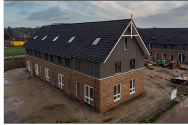
BeBo woning, gemengde gevel
