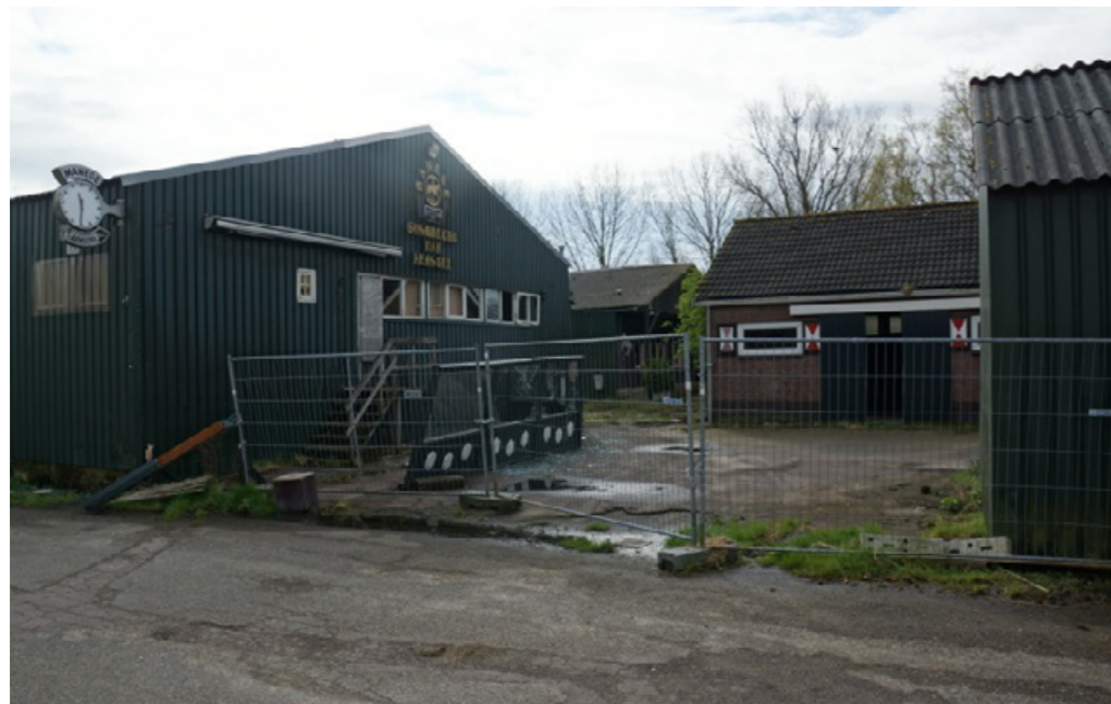
stallencomplex van de voormalige manege
