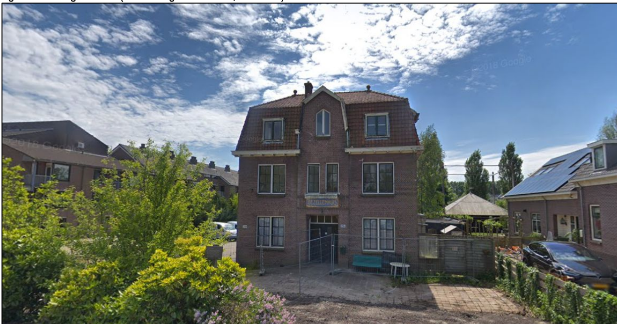
Figuur 2. Huidige situatie (bron: Google Streetview, mei 2018).
