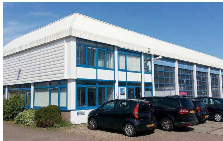
Zicht op de huidige bebouwing van de locatie Compier
