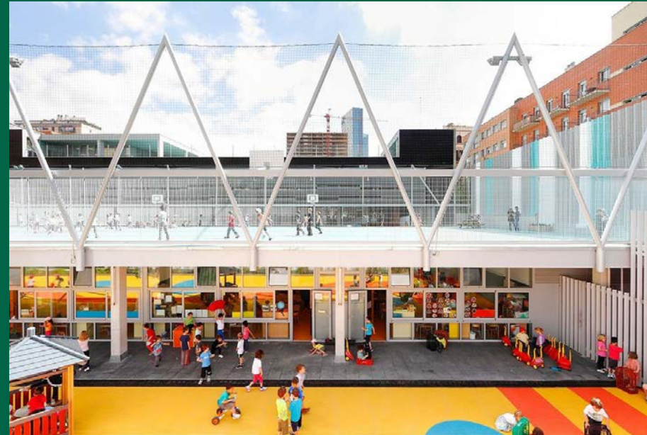
Sportveld met overstek bovenop schoolgebouw
