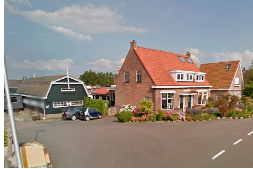
Baksteen huis met fraai industriële schuur
