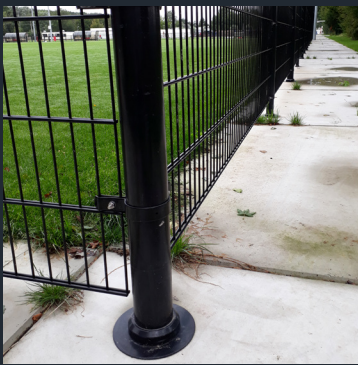
Hekwerken incl. zorgvuldige afwerking middels afdekplaat
