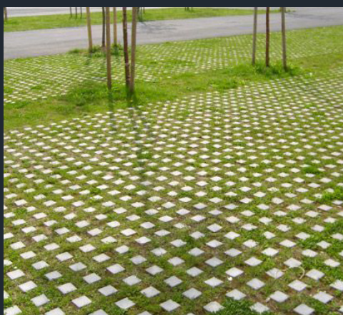
De velden - grasbetontegels op opstelplekken doelen en waar extra verharding naast de paden nodig is
