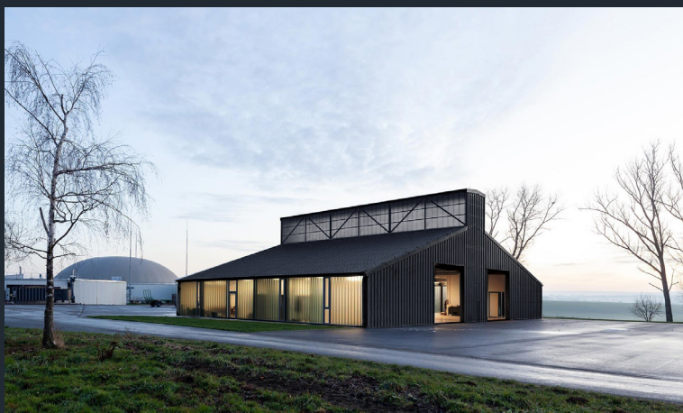
Bijgebouw met zorgvuldige overgang van wand naar dakvlak, geprofileerd plaatmateriaal
