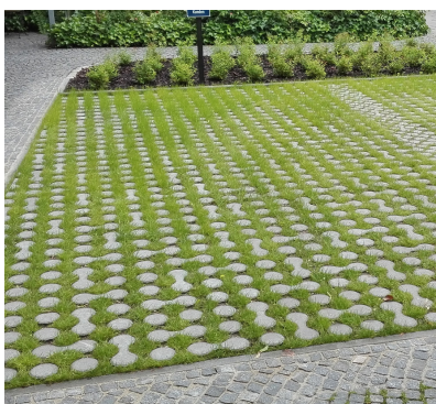
Parkeerplein - grasbetontegels, parkeermatjes
