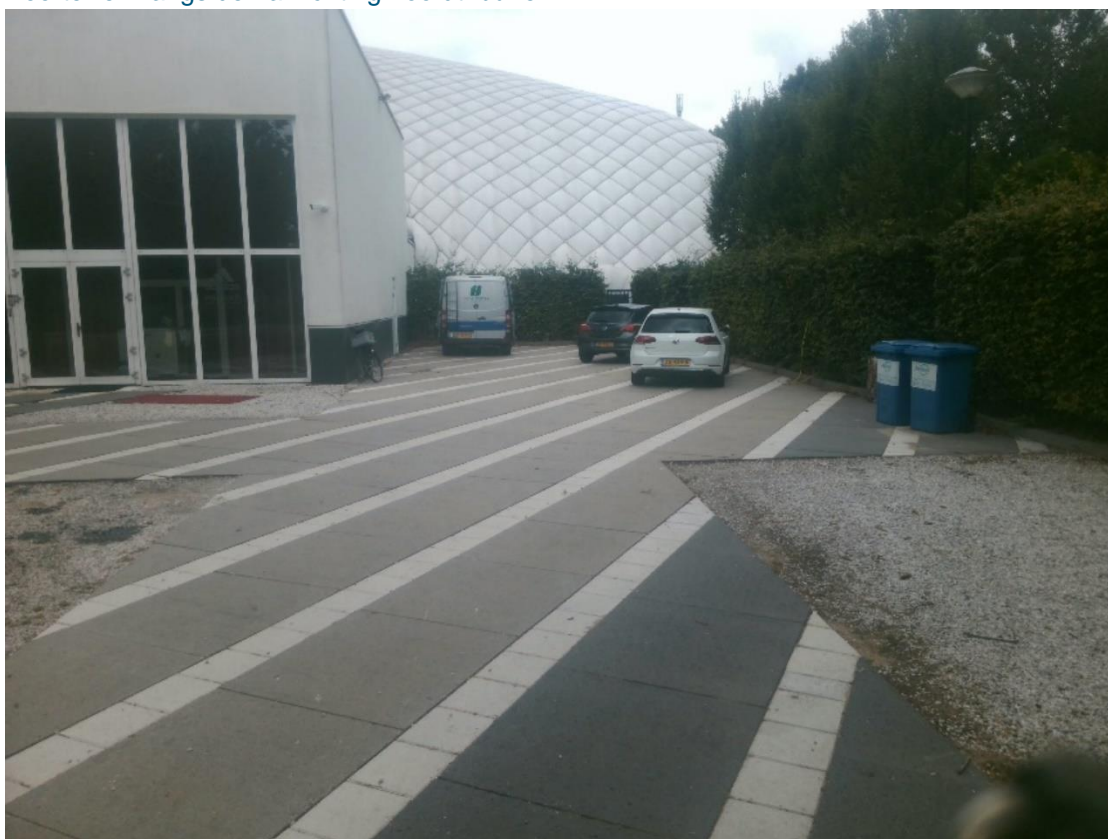
Voorterrein bij toegangsgebouw tot hal met rechts tuinafscheiding dienstwoning
