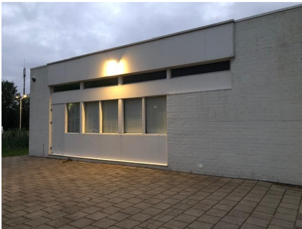
Figuur 4. Westzijde van het gebouw.
