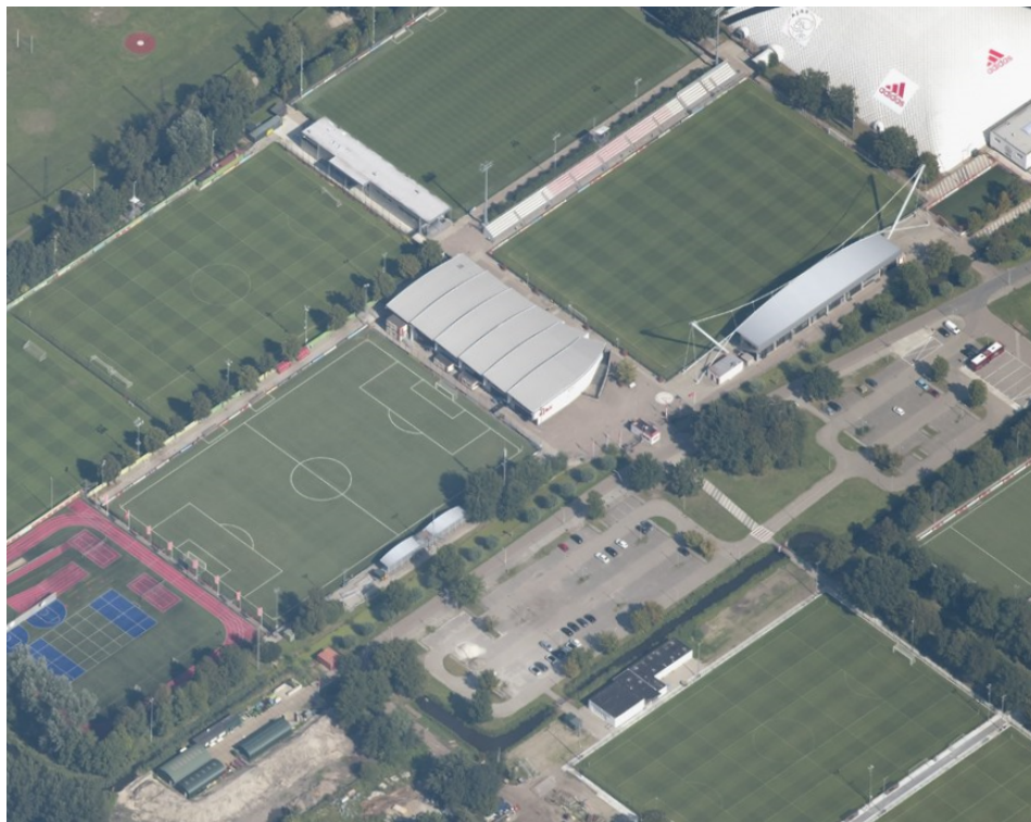
Figuur 2-2: Luchtfoto van het plangebied vanuit het zuiden (bron: Cyclomedia Streetsmart)
