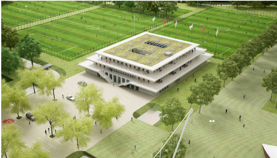
Figuur 4-3: Impressie gebouw Betaald Voetbal (bron: Masterplan De Nieuwe Toekomst 22-11-2019, NL Architects).
