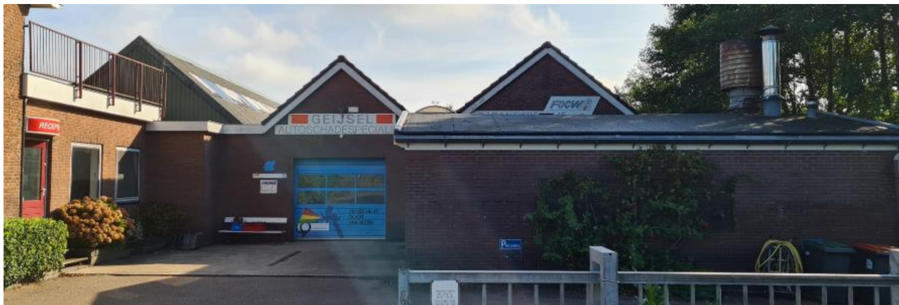
Figuur 4: De te slopen bedrijfsbebouwing gezien vanaf Holendrechteweg
