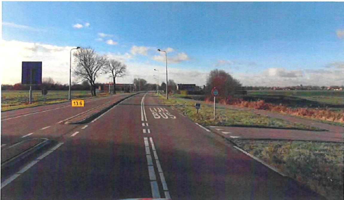
Figuur 6 Toe te passen bochtverbreeding aan de rechterzijde (bron: Verkeerskundige Onderbouwing Antea Group)
