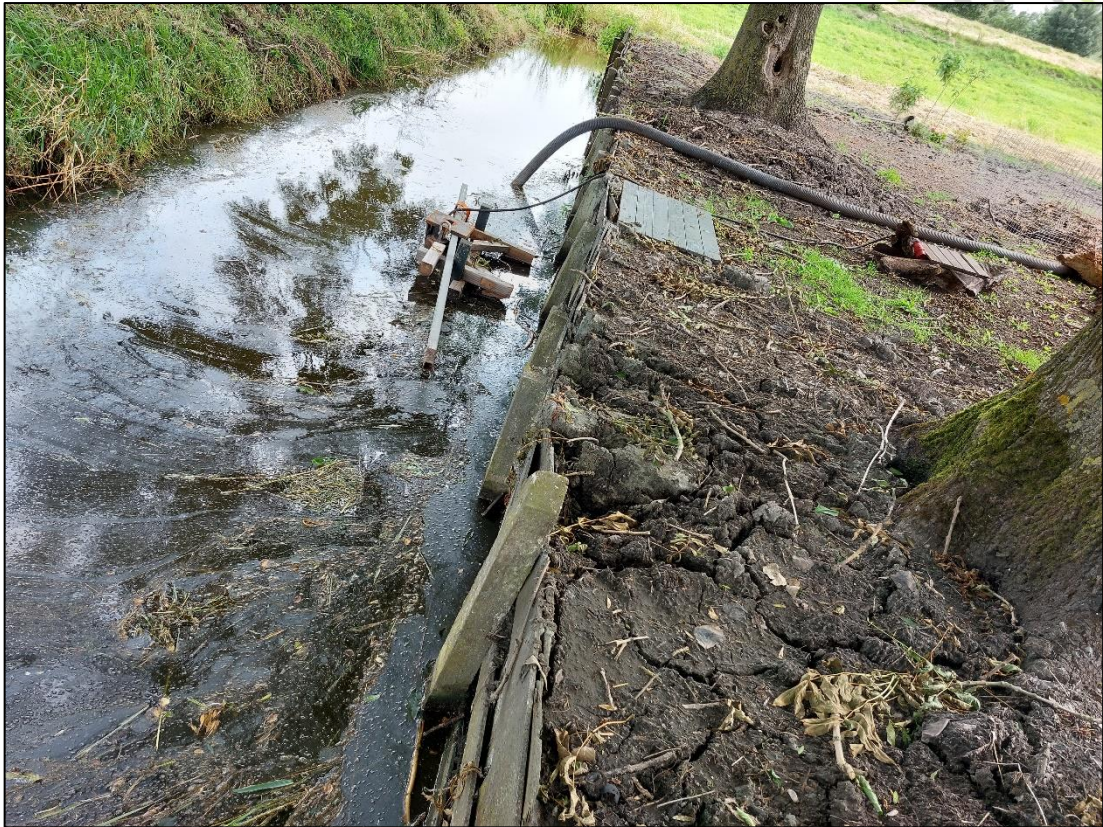
Sloot aan de achterzijde van bijgebouw 3 en 4 met een houten damwand aan de perceelzijde. Foto: G.S. Posthuma | Ecoresult B.V.
