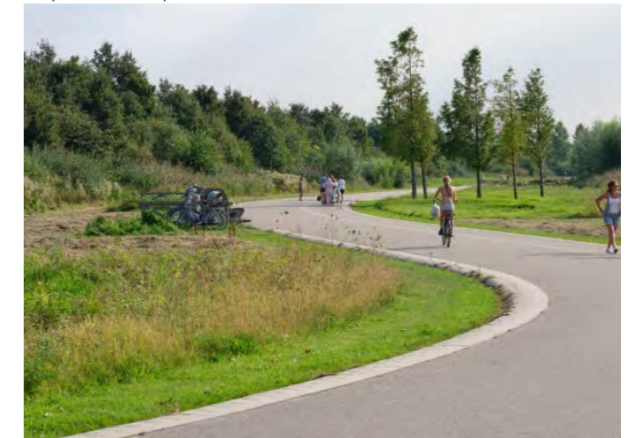
Fietspad Centraal Stadspark
