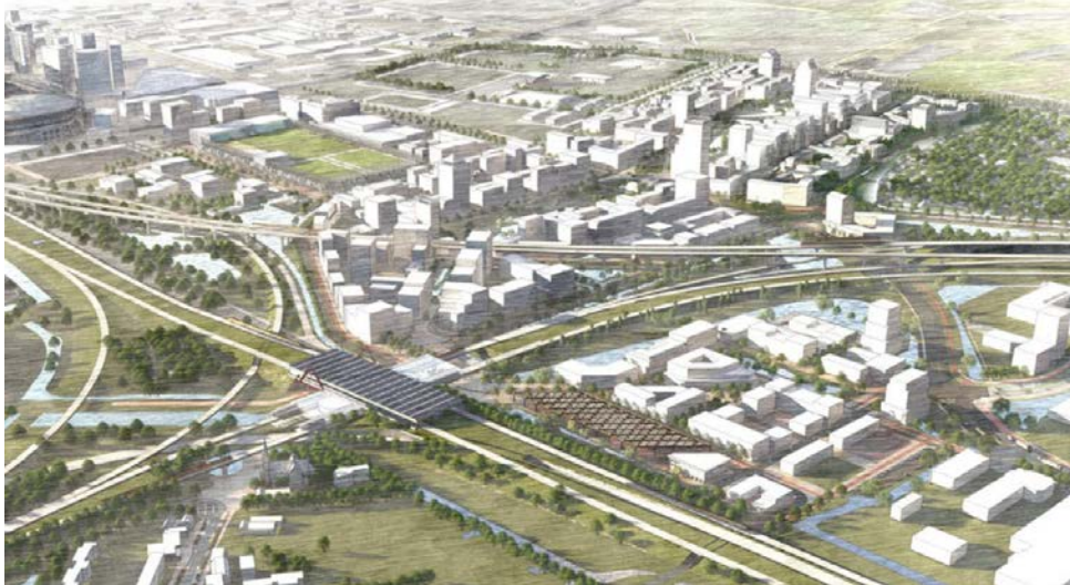
Figuur 1.3 Impressie van het plan (van noordoost naar zuidwest met station Duivendrecht op de voorgrond) (bron: concept stedenbouwkundige visie De Nieuwe Kern, december 2019)
