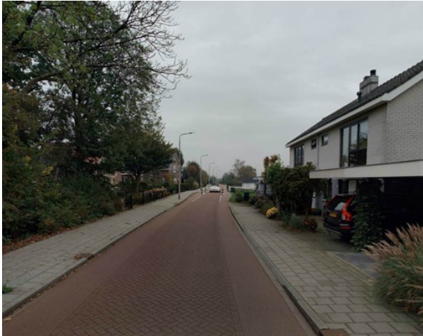
Elementenverharding zonder schades, Koningin Julianalaan
