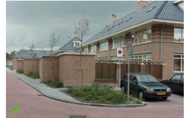
Bijgebouw van één bouwlaag waarbij het materiaal- en kleurgebruik is afgestemd op de woning.
