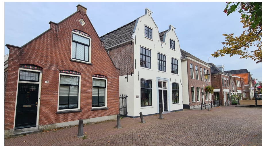
Dorps schaal en karakteristiek van historische bebouwing aan de Kerkstraat.
