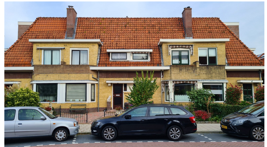
Veel plasticiteit (dieptewerking door goot, erkers e.d.) en symmetrie in de gevel van dubbele woning aan de Kloosterlaan te Duivendrecht.
