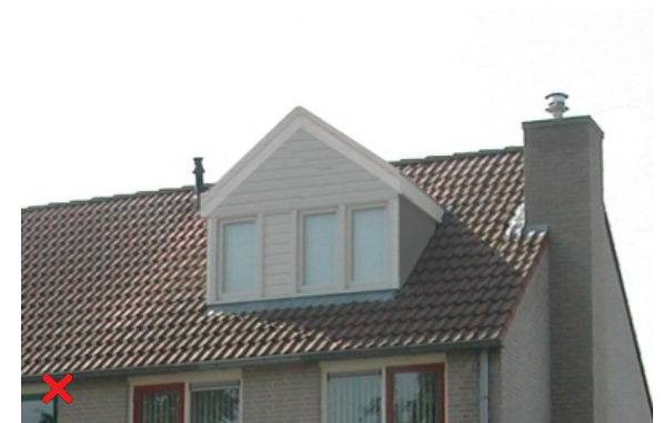
Dakkapel met puntdak, door vorm en omvang niet ondergeschikt aan het dakvlak.
