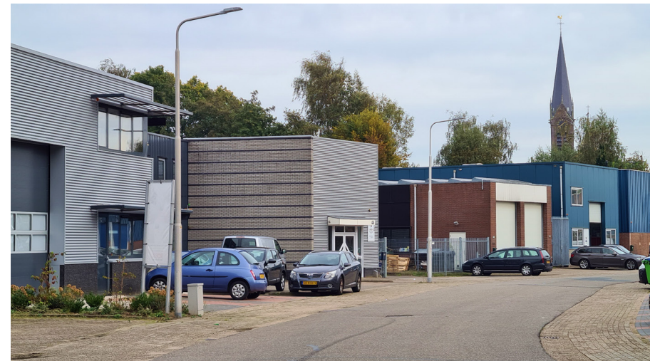
Diverse bedrijfsmatige loodsen aan de Ambachtenstraat in Ouderkerk aan de Amstel.
