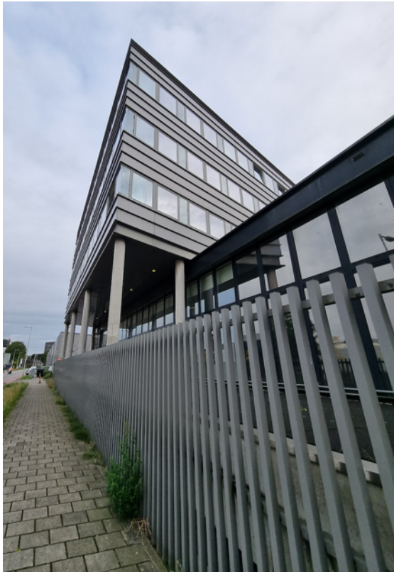
Afbeelding 8: De gevel van het kantoorpand aan de noordzijde
