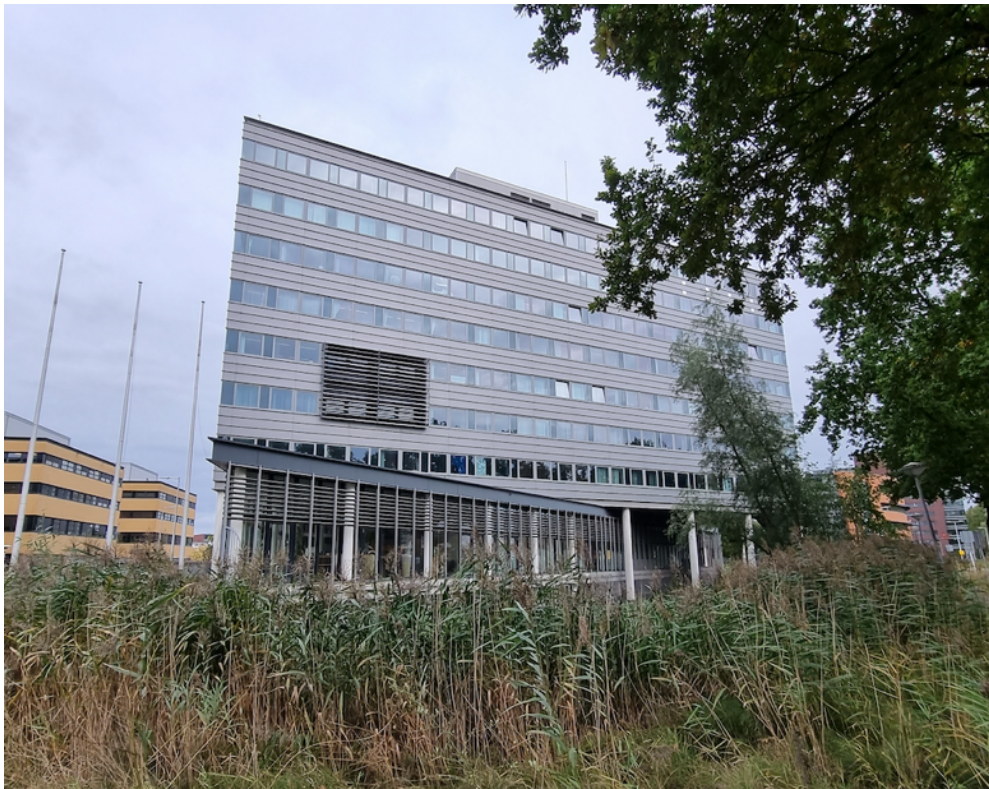
Afbeelding 6: Het kantoorpand westelijke gevel
