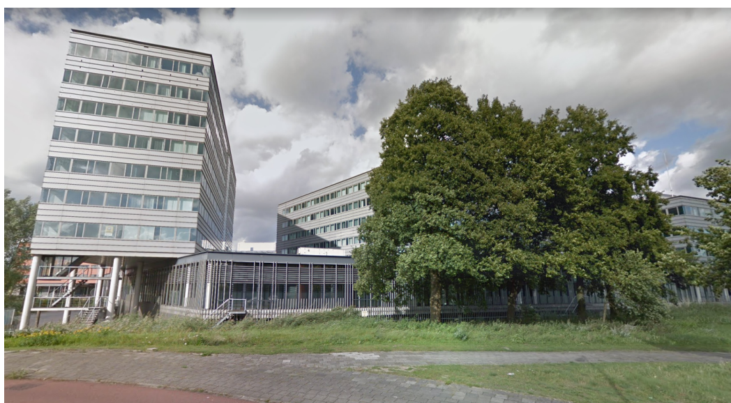
f2.2 Huidige situatie H.J.E. Wenckebachweg 144-148 (bron: Google Earth)
