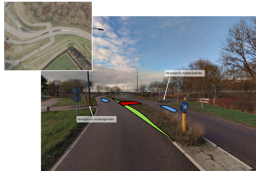
Machineweg - fietspad Burgemeester Stramanweg
