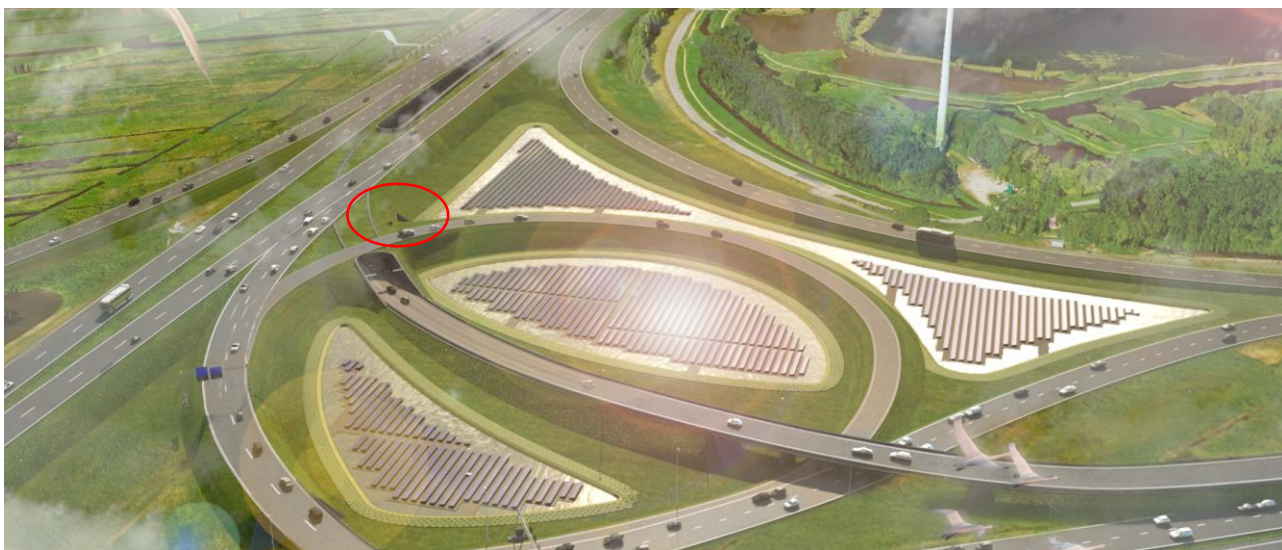
Figuur 1 Locatie technische ruimte knooppunt Holendrecht
