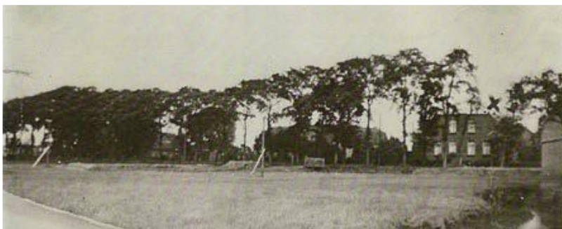
Circa 1922 – de boerderij gezien vanuit het weiland aan de andere zijde van de Rijksstraatweg.
