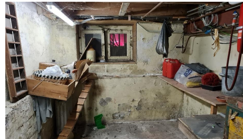
Kelder onder de keuken
