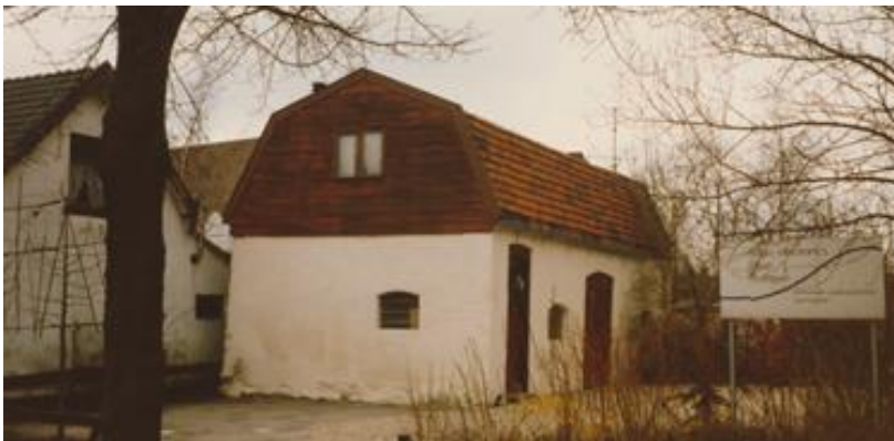
1986 – foto's van de bestaande toestand op dat moment. Woonhuis en Koeienstal zijn al verbouwd, de foto's hadden betrekking op de bouw aanvraag voor de paardenstal (onderste foto). (foto's uit het bouwarchief van de gemeente).
