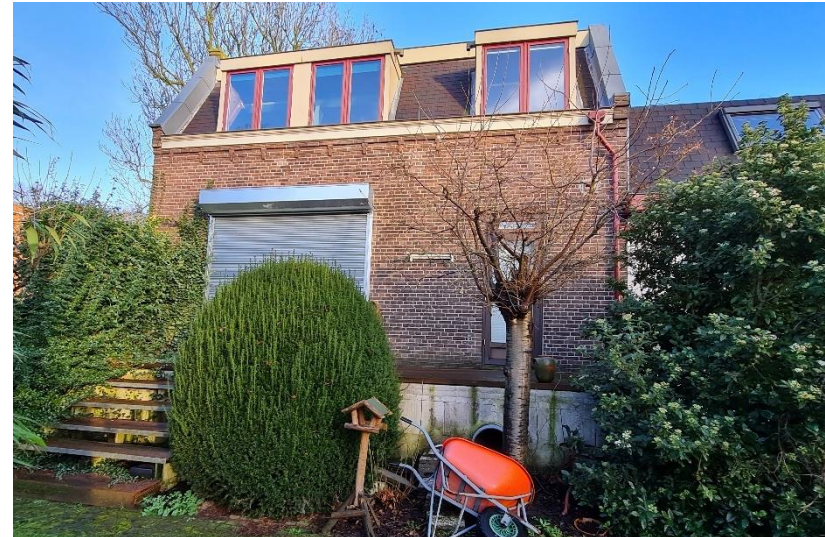
Rechterzijgevel aan de tuinzijde (met geheel nieuwe deuren en dakramen)
