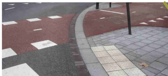
Juiste detaillering van een 50 km/uur kruispunt.
