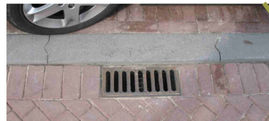
Detail van goede toepassing van een 45x20 valkolk met rollaag
